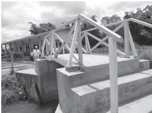
図8 橋を架け隣接村に教育の機会を生む
